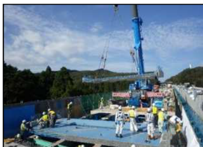
【新しい床版設置状況】
