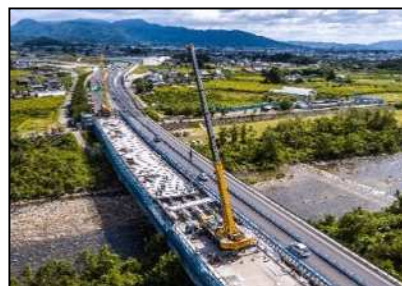
【対面通行規制状況】
