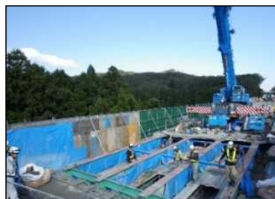
【古い床版撤去状況】
