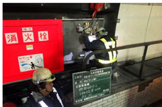
非常用設備更新
