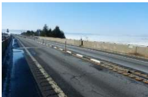
舗装路面の状況
