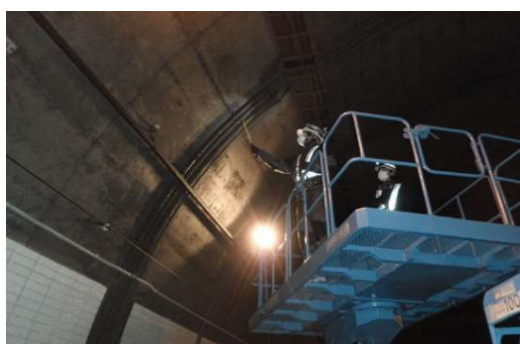
トンネル内設備の点検状況
