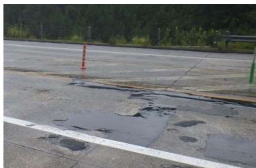
舗装路面の状況
