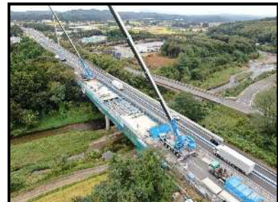
【対面通行規制状況】
