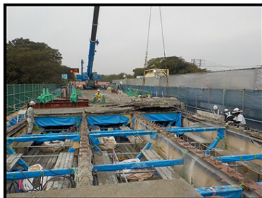
【古い床版撤去状況】
