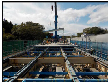
【新しい床版設置状況】
