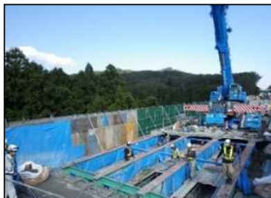
【古い床版撤去状況】
