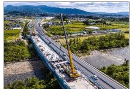
【対面通行規制状況】
