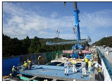
【新しい床版設置状況】
