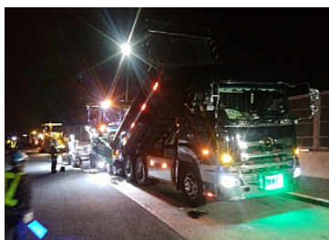
舗装補修状況
