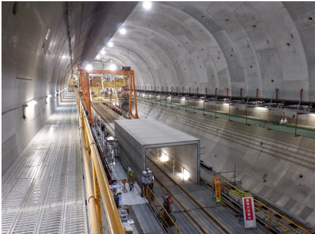
写真. トンネル坑内状況
