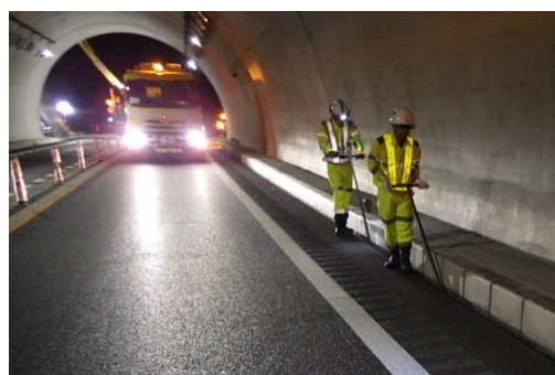
排水管清掃作業
