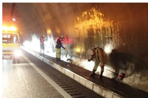
トンネル側壁清掃作業
