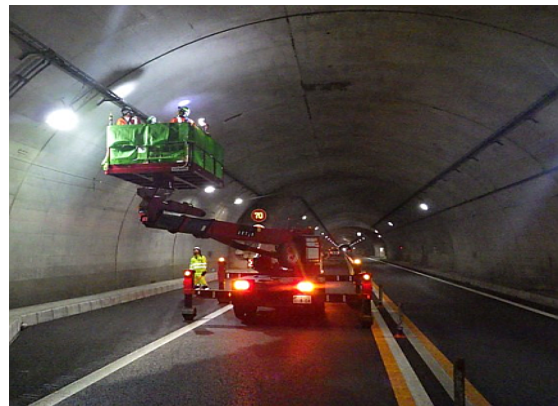
道路構造物の点検作業状況
