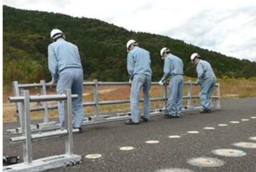
センターパイプ(部材取外し後)
