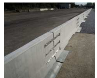
センターブロック※4
