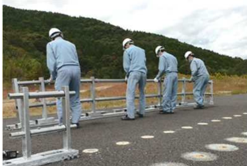
センターパイプ(部材取外し後)
