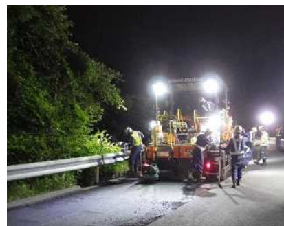
舗装補修工事 作業状況
