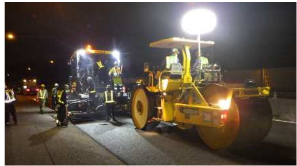
舗装補修工事 作業状況
