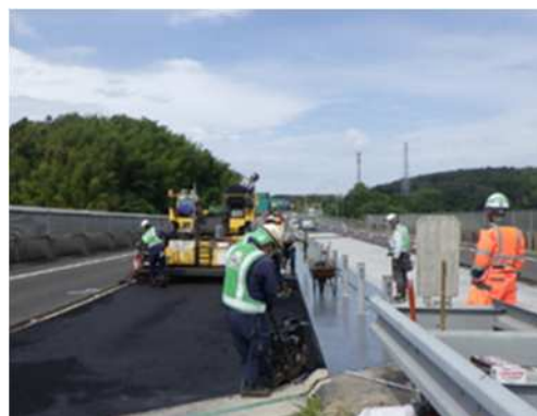
舗装補修工事 作業状況
