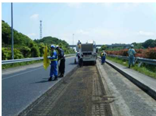
舗装補修工事 作業状況
