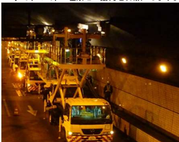
構造物点検状況
