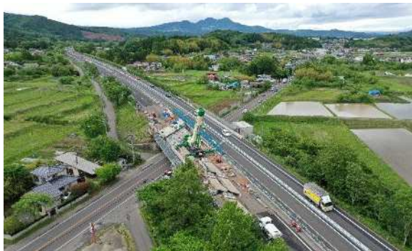
おおひらばし 東北自動車道 大平橋(下り線)の床版取替工
