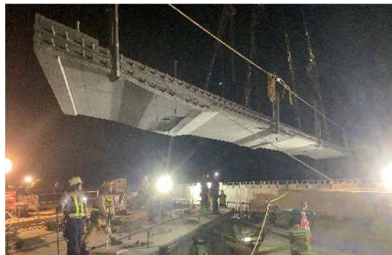
おおひらばし 東北自動車道 大平橋(下り線)の床版取替工
