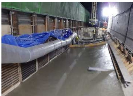
③ インバートコンクリート打設の完了
