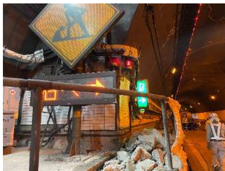
監視員通路撤去状況
