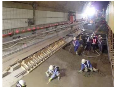
② 掘削～型枠～コンクリート打設
