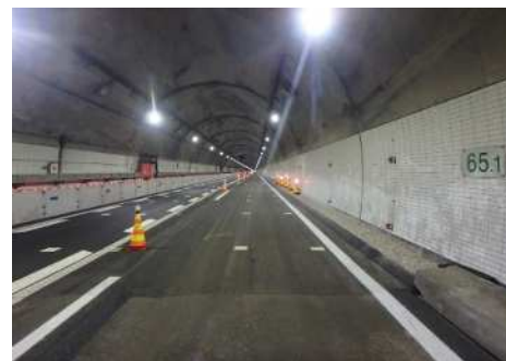
④ 舗装(完了)
