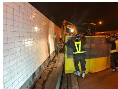
監査路撤去状況
