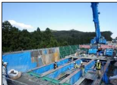
【古い床版撤去状況】
