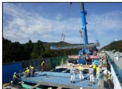
【新しい床版設置状況】
