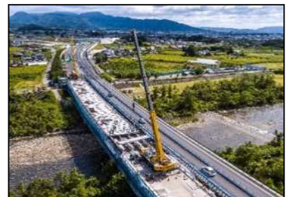
【対面通行規制状況】
