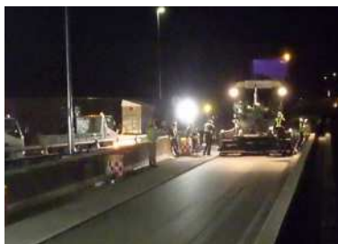
夜間舗設作業イメージ
