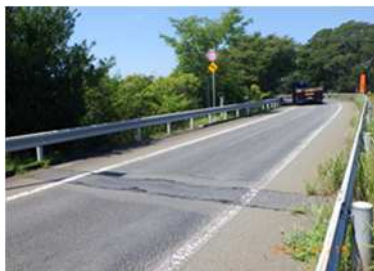
加須IC 現況舗装状況
