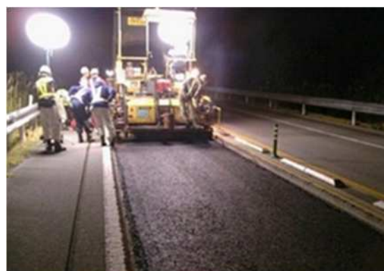
舗装補修工事 作業状況
