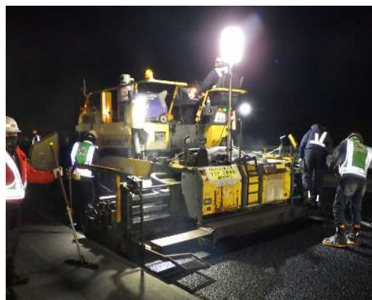
舗装補修工事 作業状況
