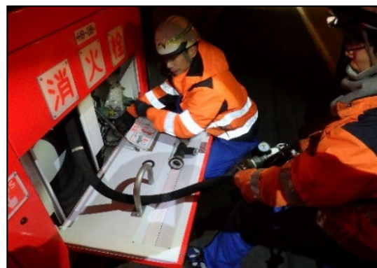
トンネル点検例
