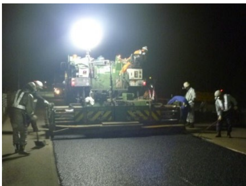
路面補修工事例
