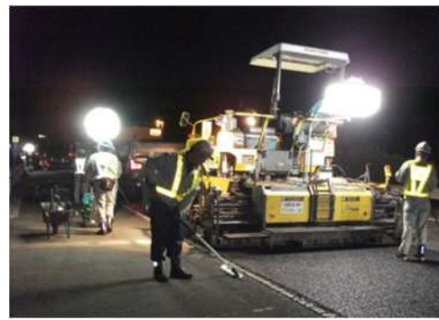
舗装補修工事 作業状況
