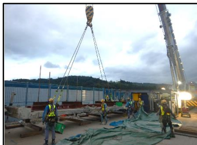
【古い床版撤去状況】
