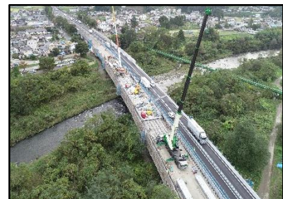
【対面通行規制状況】
