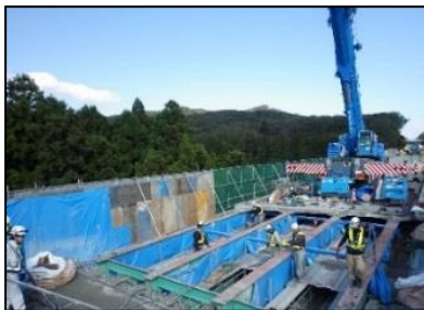
【古い床版撤去状況】
