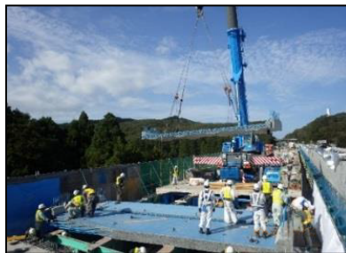
【新しい床版設置状況】
