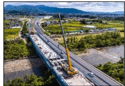
【対面通行規制状況】
