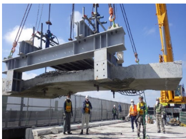
【古い床版撤去状況】
