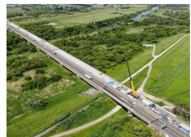
【対面通行規制状況】
