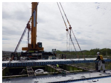
【新しい床版設置状況】
