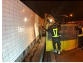
監視員通路撤去状況
