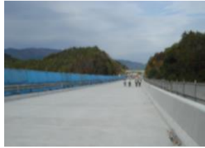
施工完了後の状況
