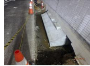
覆工受台完了状況
