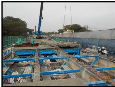
【古い床版撤去状況】
