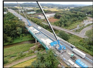
【対面通行規制状況】
