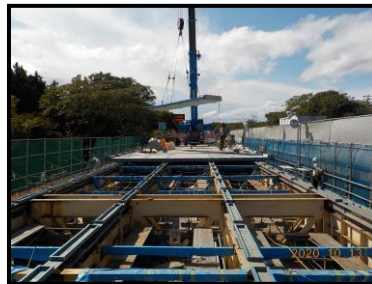
【新しい床版設置状況】
