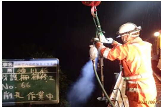
施工中(イメージ)
