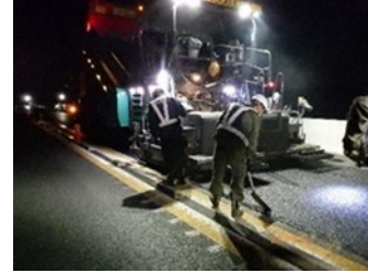
舗装補修工事
