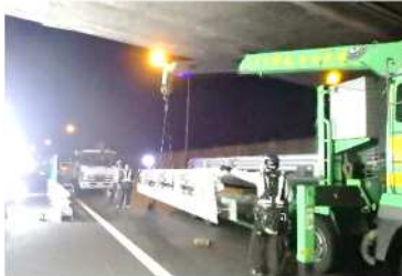
仮設防護柵設置状況
