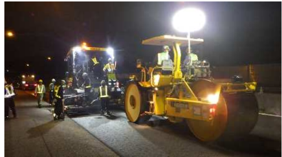
舗装補修工事 作業状況
