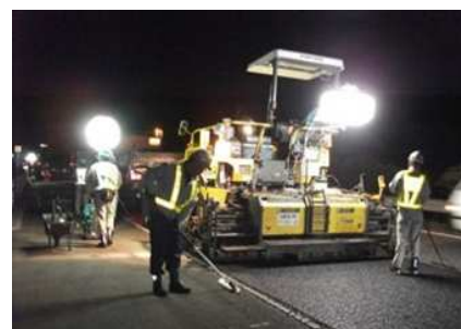
舗装補修工事 作業状況
