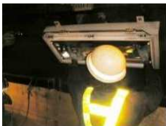
トンネル照明設備清掃・点検
