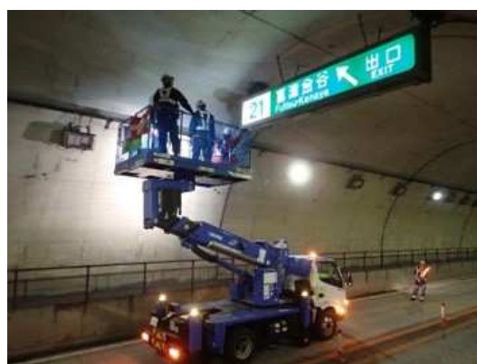
道路構造物点検作業状況
