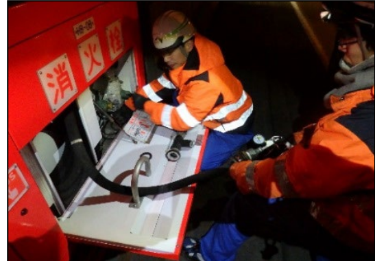
トンネル点検例
