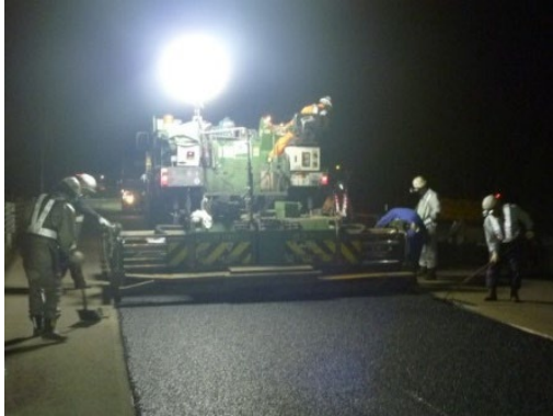
路面補修工事例
