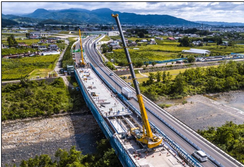
【対面通行規制状況】
