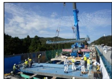
【新しい床版設置状況】
