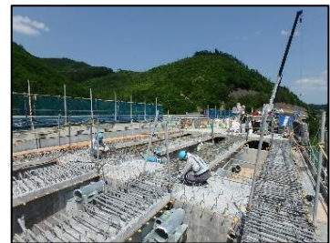
【古い床版撤去状況】
