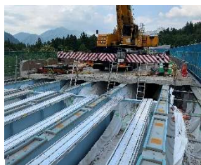
【古い床版の撤去状況】
