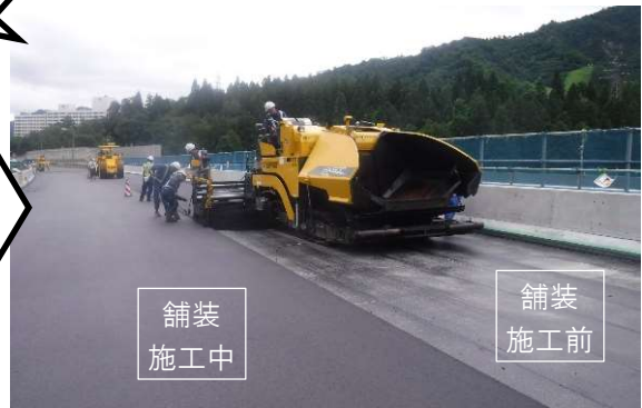
④舗装の施工
