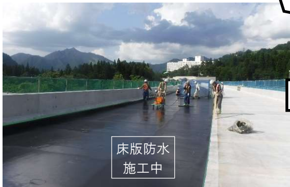
③床版防水の施工
