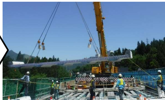
②新設プレキャストコンクリート床版の設置
