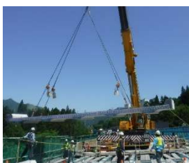
【新しい床版の設置状況】
