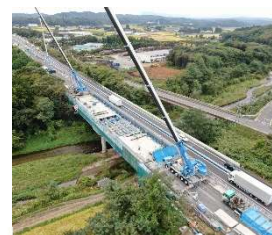
【対面通行規制状況】
