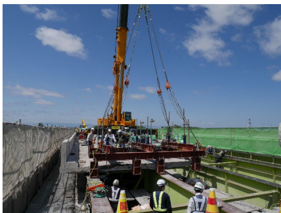
【古い床版撤去状況】
