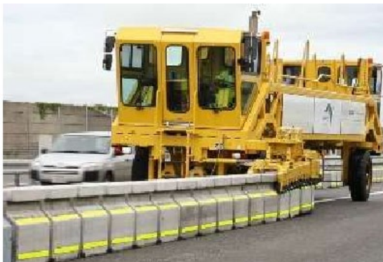
【写真①】ロードジッパーシステムによる車線切替状況】
