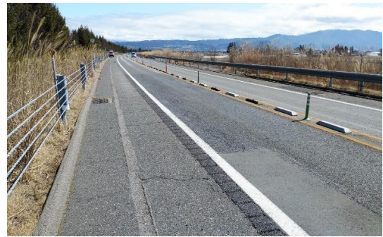
舗装路面の状況
