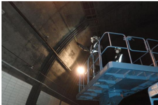
トンネル内設備の点検状況
