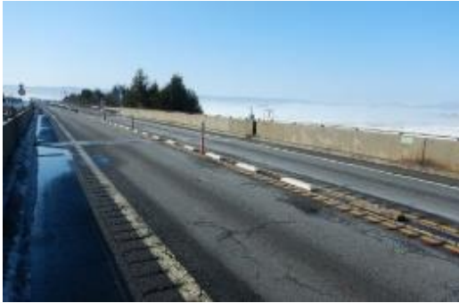
舗装路面の状況
