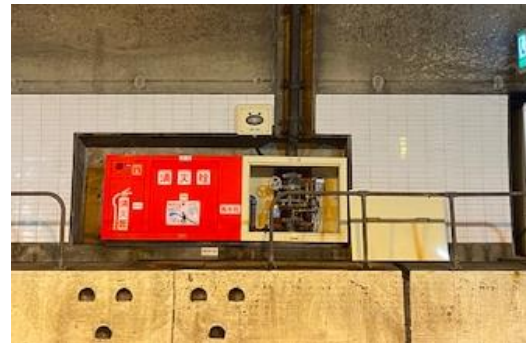
非常用設備更新
