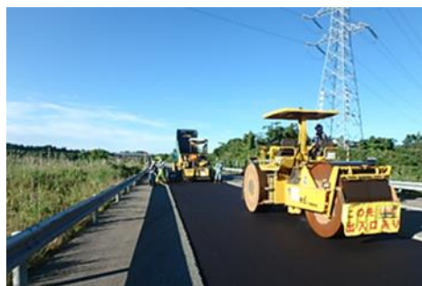
施工中(イメージ)
