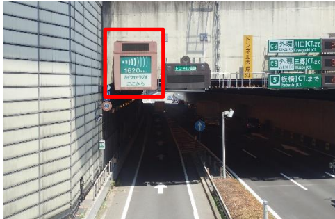
始点案内標識板 現地状況
