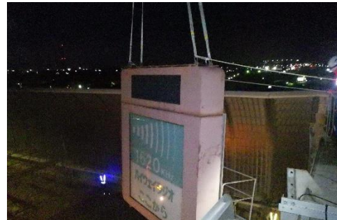
始点案内標識板更新工事 作業状況
