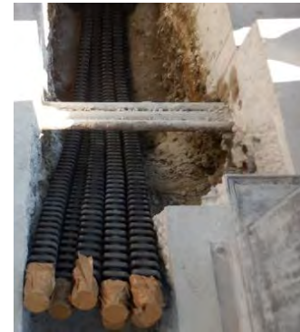
電線管の設置
