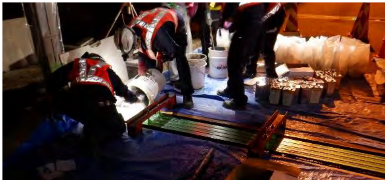
車両検知器の設置
