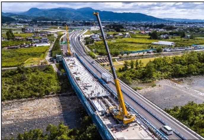
【対面通行規制状況】
