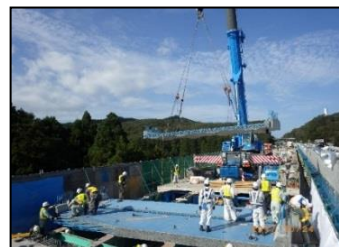
【新しい床版設置状況】
