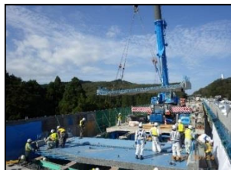
【新しい床版設置状況】
