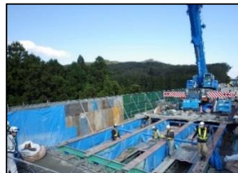
【古い床版撤去状況】
