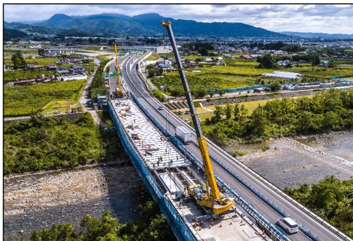
【対面通行規制状況】
