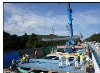
【新しい床版設置状況】
