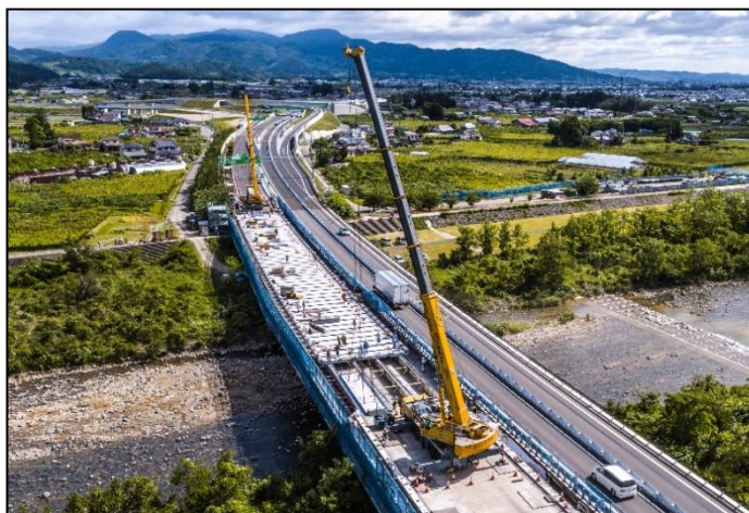
【対面通行規制状況】
