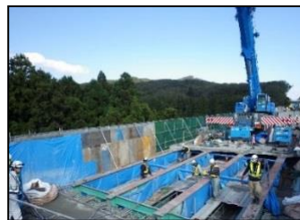
【古い床版撤去状況】
