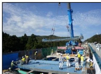
【新しい床版設置状況】
