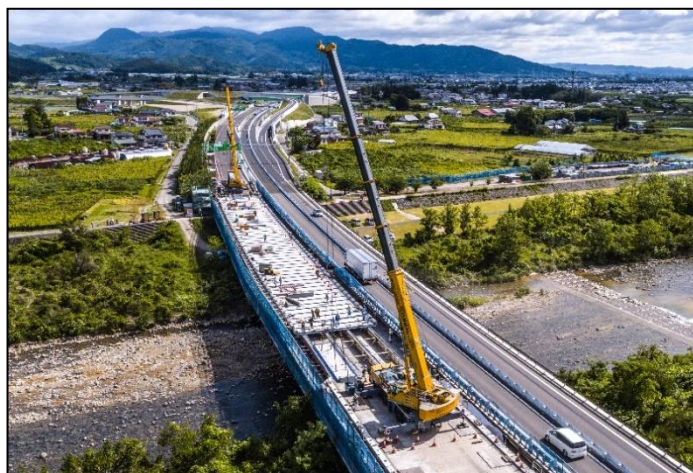
【対面通行規制状況】
