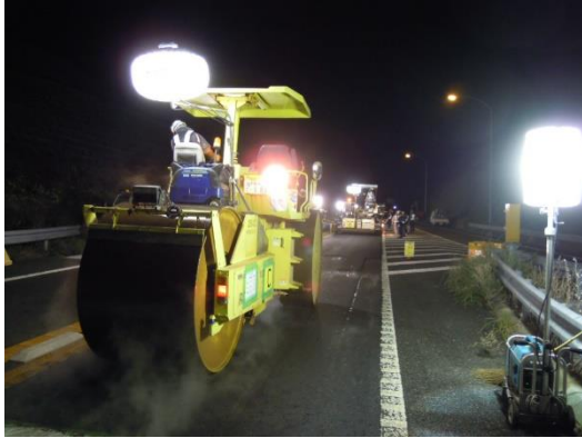
舗装補修工事
