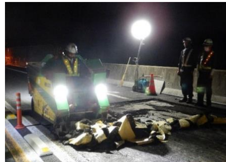
舗装補修工事 作業状況
