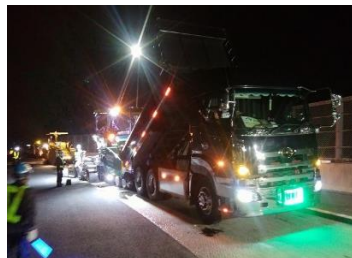
舗装補修状況
