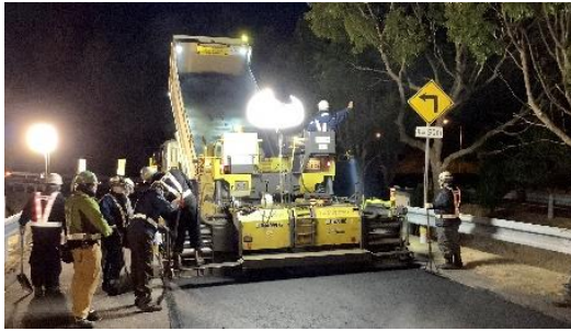
舗装補修工事 作業状況
