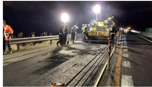
路面段差修正 作業状況
